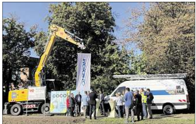
Mit einem Spatenstich wurde der Ausbau des Oberleitungsnetzes offiziell gestartet. Die Karte zeigt, um welche Strecken das bestehende Netz für die Batterie-Oberleitungsbusse in den kommenden zwei Jahren erweitert wird. Fotos: eis
